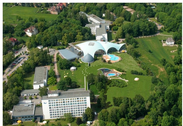
Hotel an der Therme Bad Sulza, Toskana Therme Bad Sulza und Klinikzentrum Bad Sulza / © Toskanaworld
